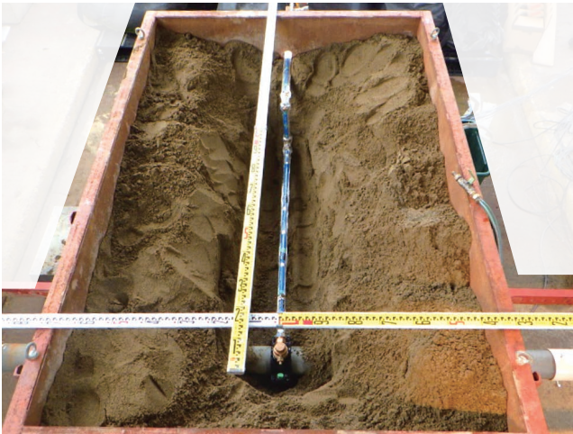
写真 土槽内の給水管設置状況
