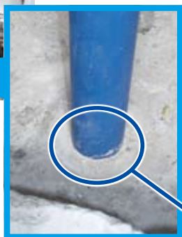
給水立て管の スラブ貫通部
